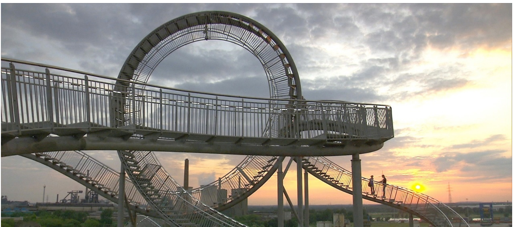
17 Pfeiler stützen die gewaltige Installation.
