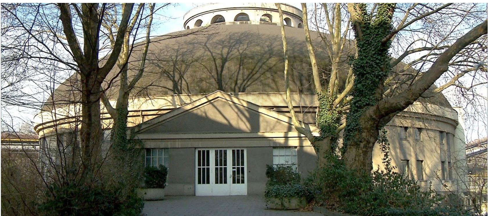
Das Pumpwerk ist ein Beispiel höchster Ingenieurbaukunst.
