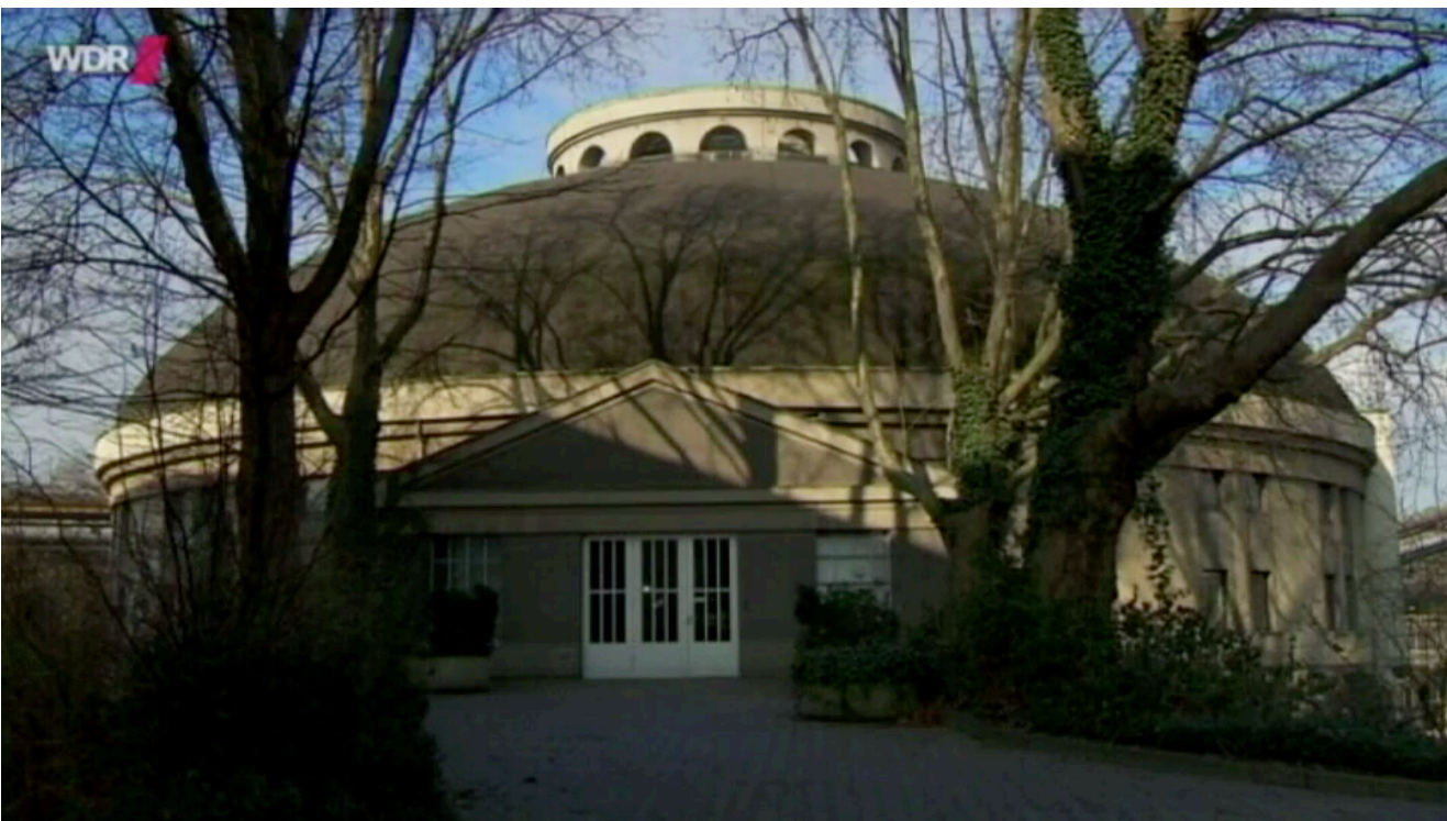
Meisterwerk-Video: Pumpwerk Alte Emscher
