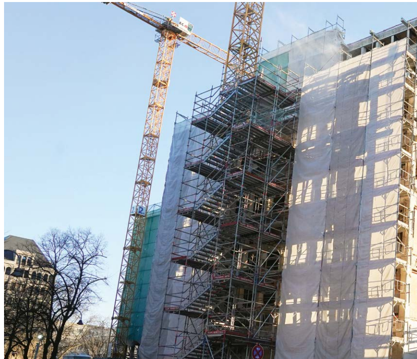
Filmhausbaustelle am Kölner Appellhofplatz
